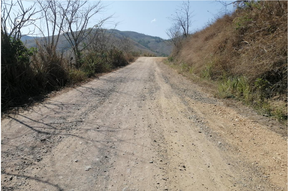
Figura 131. Vía lastrada hacia la parroquia Santa Rufina. Chaguarpamba 2020 Elaborado por: Equipo técnico Planning & Solution S.A (2020).
