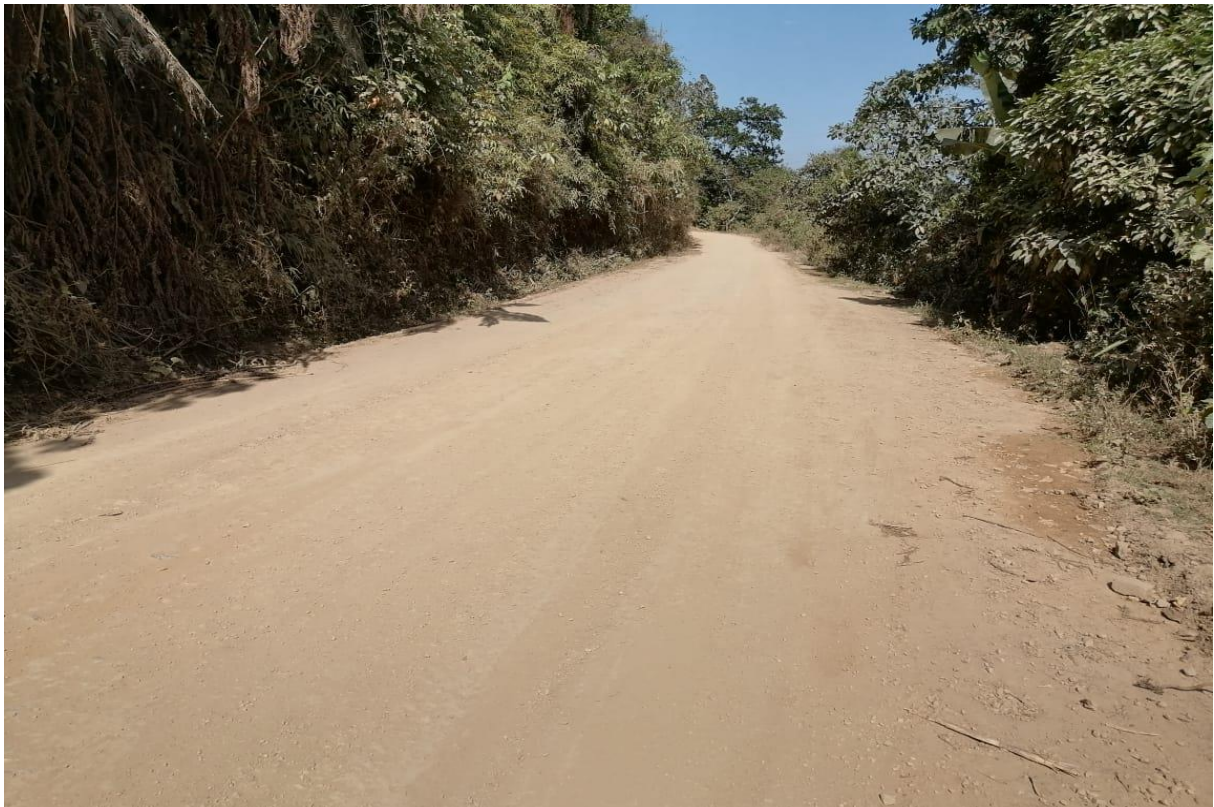
Figura 132. Vía lastrada hacia la parroquia Amarillos. Chaguarpamba 2020 Elaborado por: Equipo técnico Planning & Solution S.A (2020).
