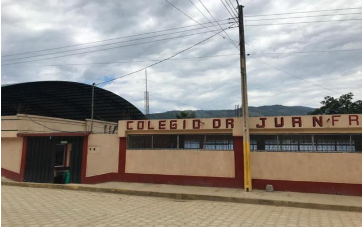
Figura 109. Colegio de Bachillerato DR Juan Francisco Ontaneda, Parroquia Buenavista Elaborado por: Equipo técnico Planning & Solution S.A (2020).
