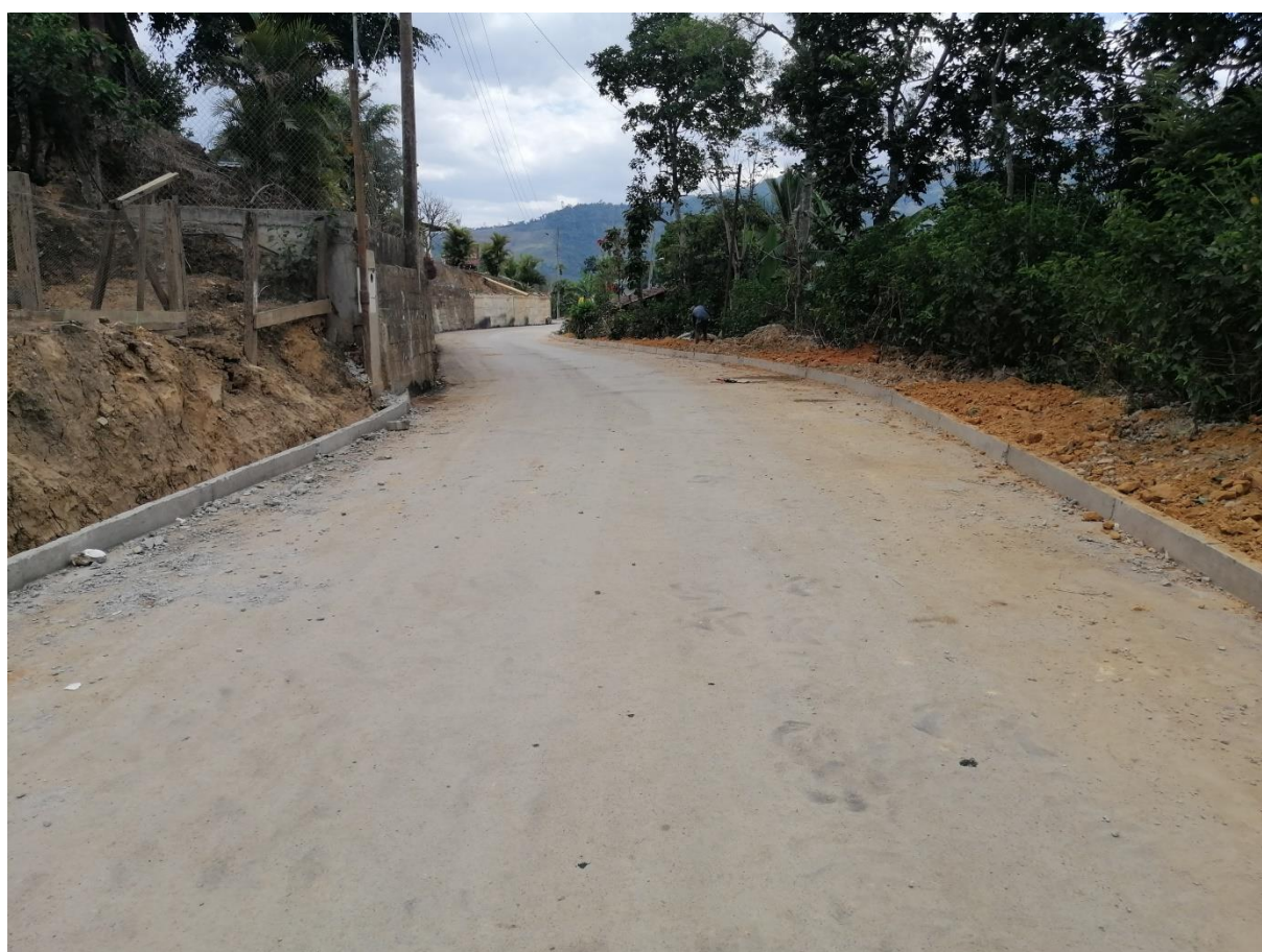
Figura 130. Vía asfaltada hacia la parroquia Buenavista. Chaguarpamba 2020
