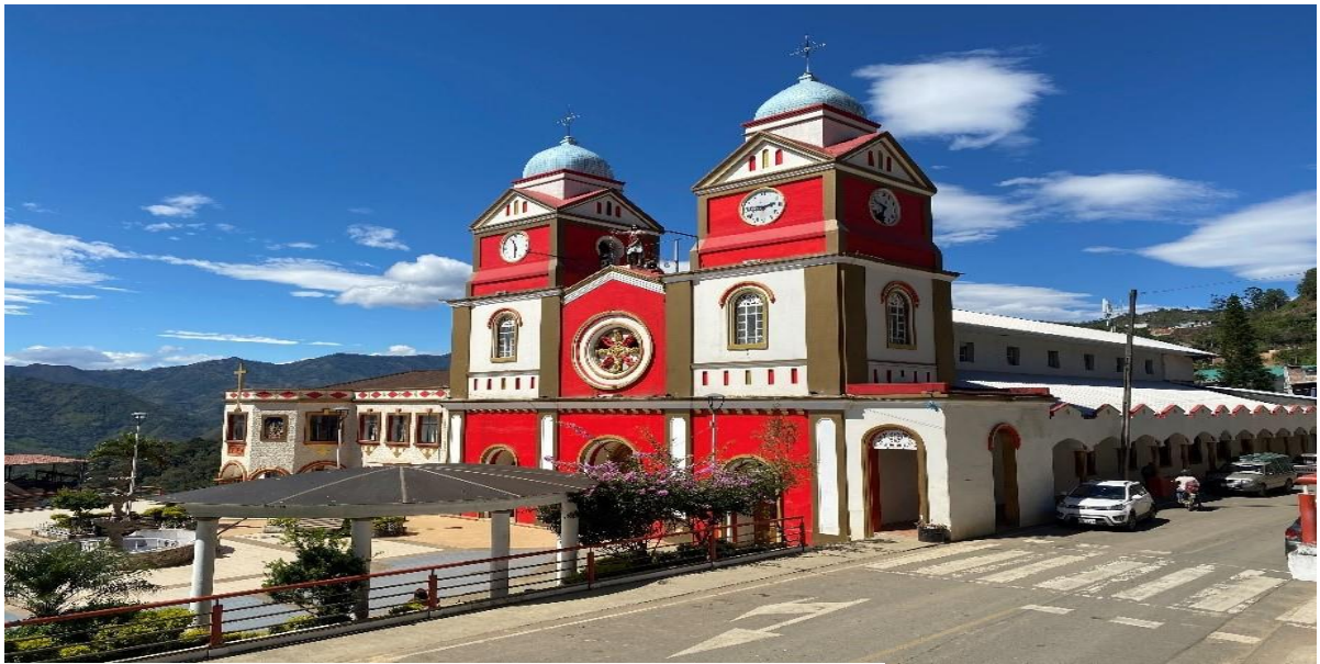
Figura 85. Iglesia Matriz de Chaguarpamba Fuente: GAD cantonal Chaguarpamba.
